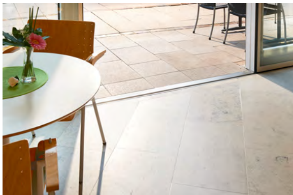
Figura 53 Uscio verso un'area esterna, accessibile senza gradini né dislivelli
