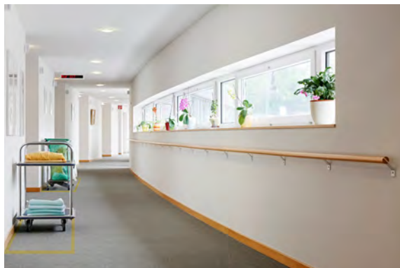
Figura 46 Corrimano su un lato del corridoio con zona di appoggio sul lato opposto
