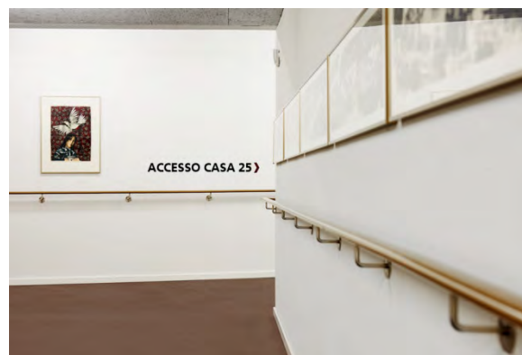
Figura 48 Corrimano nel corridoio su entrambi i lati
