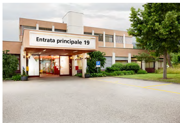
Figura 34 Parcheggio nelle vicinanze di un accesso privo di barriere
