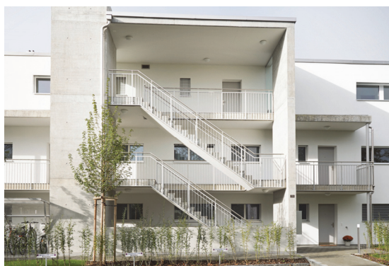
Figura 5 Scala dritta per il collegamento interno dell'edificio posta nel porticato
