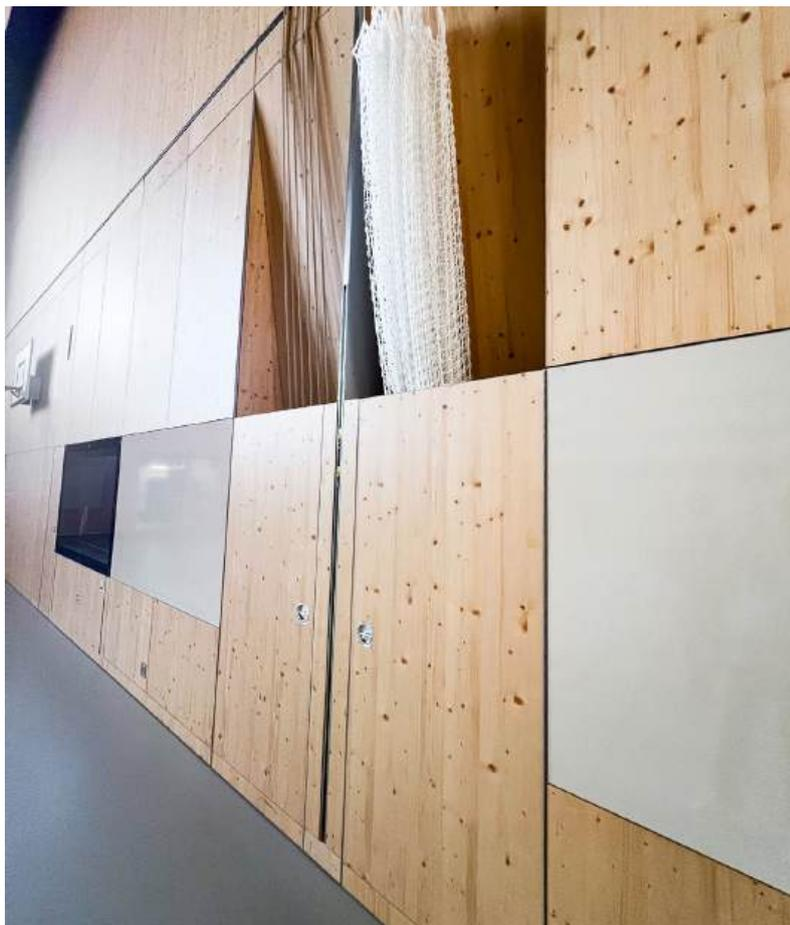
Figura 8: corde da arrampicata e dispositivi di regolazione dell'altezza in nicchia di parete chiudibile a chiave
